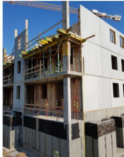
Példa erkélyek alátámasztására
