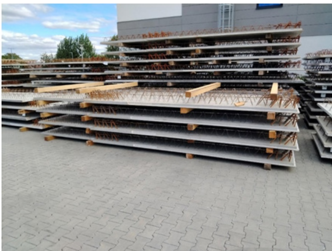
10 x 10-es átmérőjű 2,4 m hosszú párnafákat helyezünk a rakatok alá és minden olyan elempár közé, ahol a nyírótrigon kiemelkedik az elemből.
